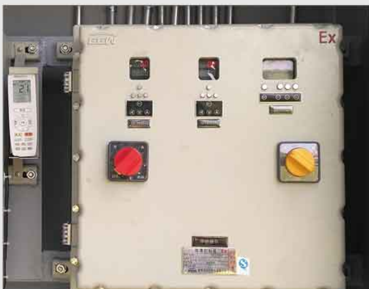
防爆配电及控制系统
