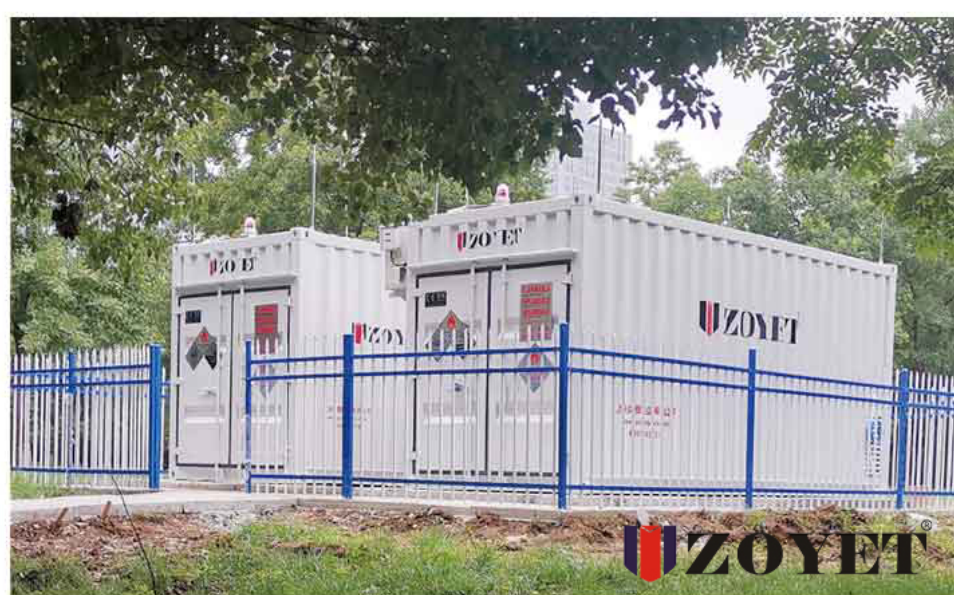
明基医院项目
